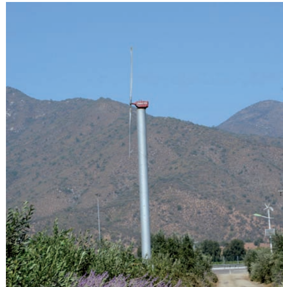
* Ventiladores para el control de heladas.
